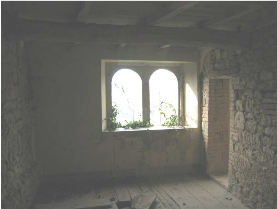
Foto n. 54: Casa a valle del portale. Finestrone panoramico
